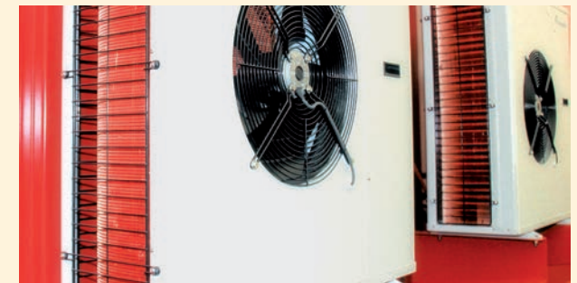
Splitsystem Außeneinheit Split system outdoor unit
