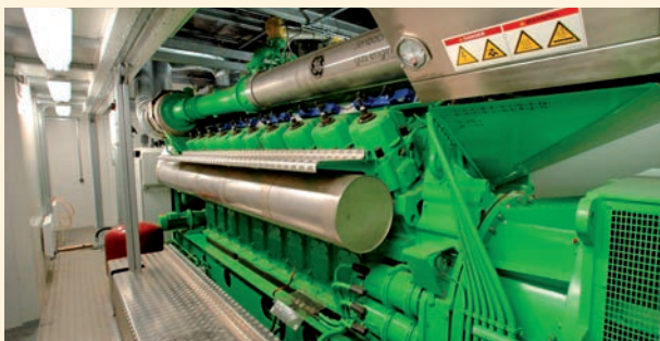
Gasmotor mit bis zu 4,4 MW E-Leistung Gas engine with up to 4.4 MW E-power
